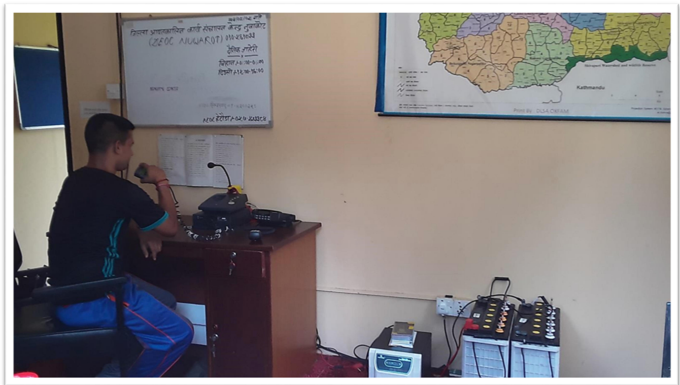
जिल्ला आपतकालिन कार्य संचालन केन्द्रको संचार सेट पावर ब्याकअप सहितको मर्मत गरिएपछि पुनः संचालन गर्दै
